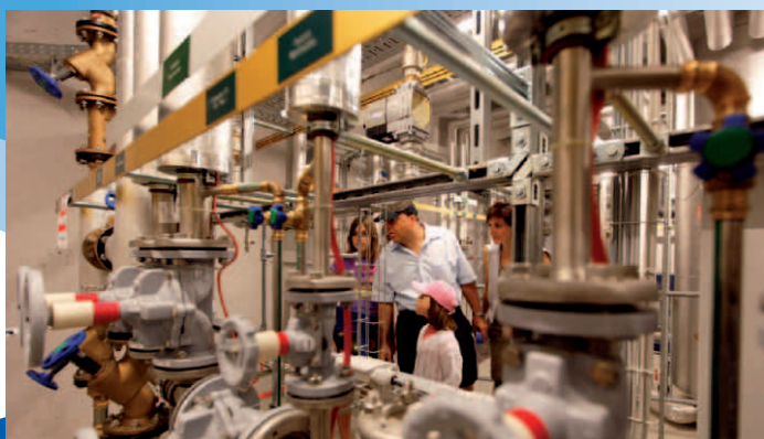
Modernste Technik im Untergeschoss, Solarkraftwerk auf dem Dach: Die BOSSARD Arena entspricht dem Minergie Standard
